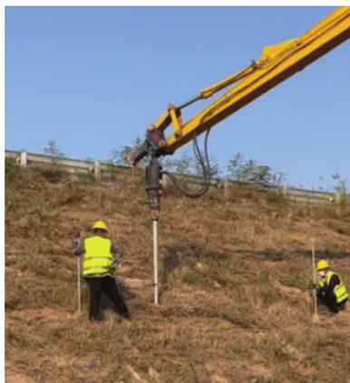
图2 钢管螺旋桩的沉桩施工照片
