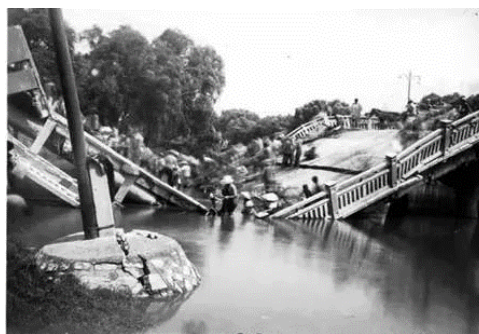
图 3 1964 年唐山地震中胜利桥倒塌 [26]
