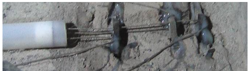
(b) 安装完成的测点锚头和套管
