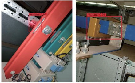
(a) 正常 I 类绝缘子 (b) 正常 II 类绝缘子
