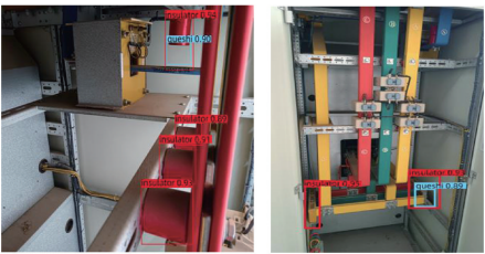
(e) 缺失 I 类绝缘子 (e) 缺失 II 类绝缘子
