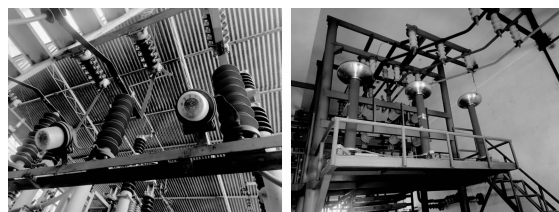
图15 加装的避雷器及放电电阻
