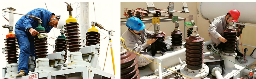
图1 难于清洁部位须停电人工清洗图示
