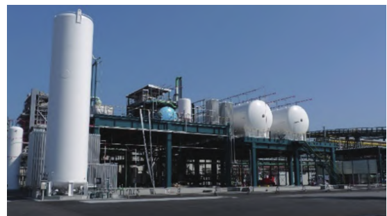
图 7 韩国林德氢气液化装置
