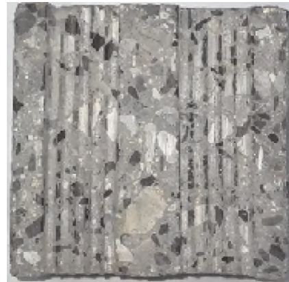
图1 基底混凝土粗糙度处理
