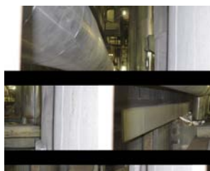
图 3 2AB8 梁构件弯曲和扭转变形
