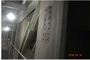
图 7 原设计预留的中间支座斜撑结点
