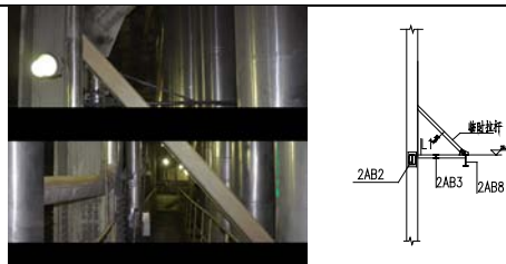
图 6 2AB8 梁构件新增的临时拉杆
