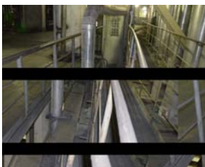
图 4 通道严重倾斜、扭曲
