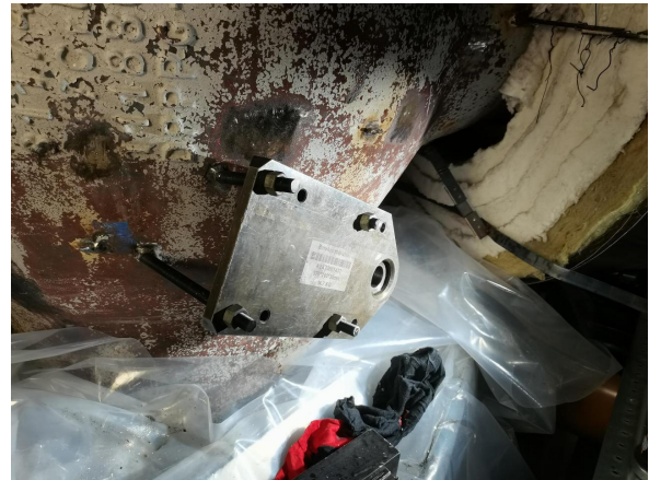
磁力钻固定支撑板安装图
