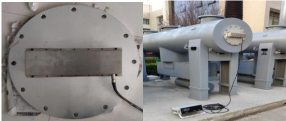
图12 法兰在线检测的安装位置
