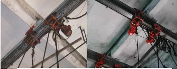
图2 行走小车电机改造前后对比图
